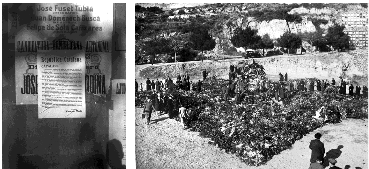
De dreta a esquerra: cartell de la proclamació de la República Catalana (ANC-Fons Gabrel Casas, 1931), i tomba de Macià al cementiri nou de Montjuïc (ANC-Fons Brangulí, Fotògrafs, 1933).
